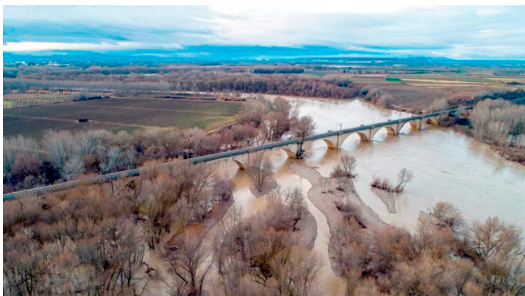
Curage en Alfaro (La Rioja) tras la acción de una crecida en el río Ebro.
