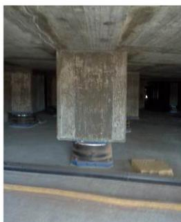
Imagen 1. Ejemplo de aislador sísmico
