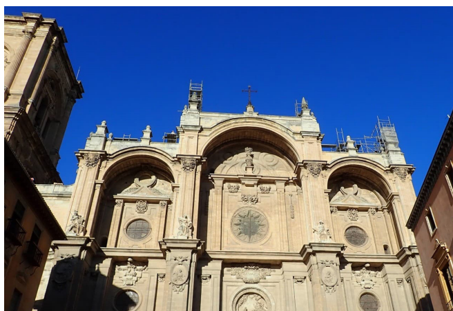
Figura 8. Catedral de Granada. Medidas auxiliares para las labores de emergencia de retirada de elementos decorativos de fachada.
