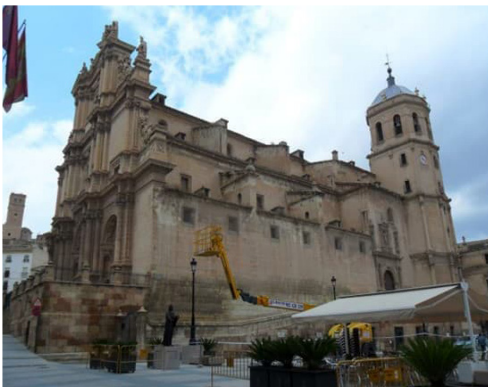
Figura 2. Fotografía de la antigua colegiata de San Patricio. Se ve una de las grúas empleadas en la retirada de elementos en altura con riesgo de caída.
