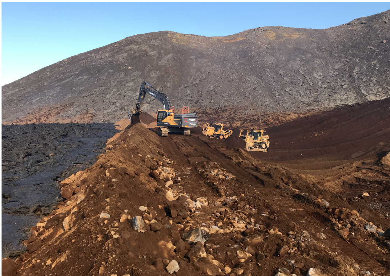
Figura 7. Elevación de emergencia de la presa oriental, un día antes del desbordamiento.
