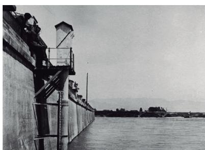
Figura 5. Escala de la estación de aforos EA 9096 Segre en Balaguer.
