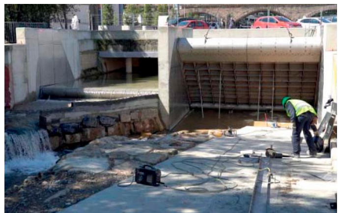
Instalación compuertas flotantes en la confluencia de los ríos Queiles y Ebro. Tudela (NA).
