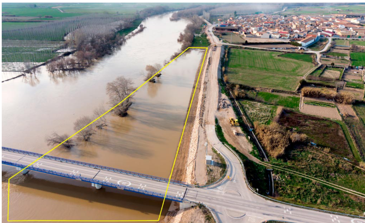
Pradilla de Ebro, aumento permeabilidad puente sobre el río Ebro.
