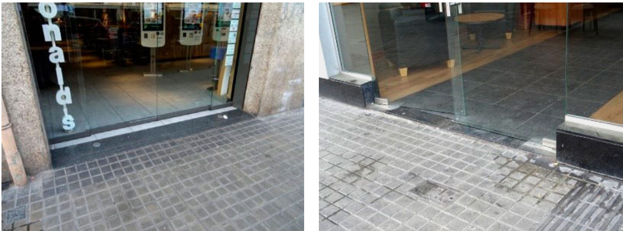
Figura 7. Puertas de acceso y escalones, prácticamente inexistentes, de dos comercios de la ciudad de Barcelona.
