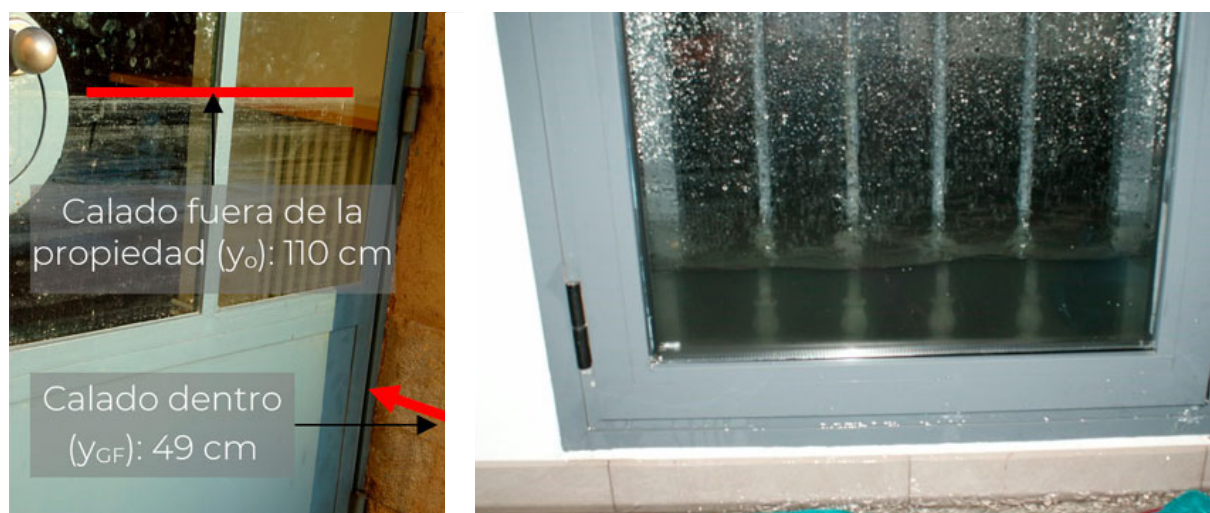
Figura 8. Marcas de los calados alcanzados por el agua tras un evento de inundación, en el interior y exterior de la propiedad.
