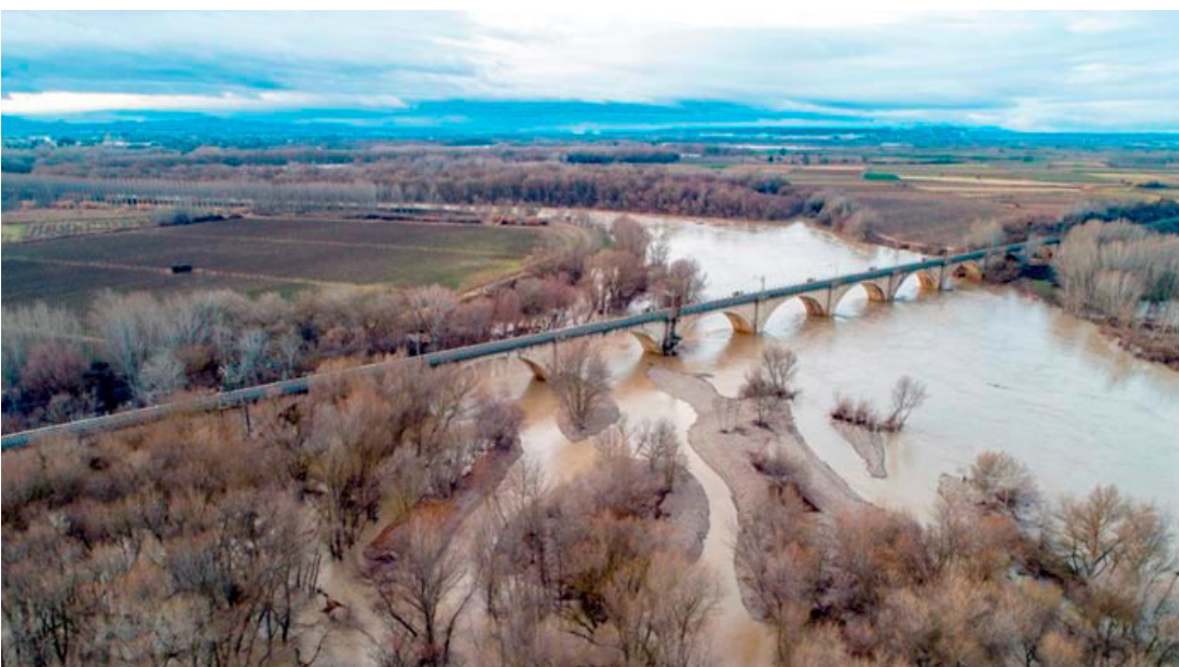
■ Curage en Alfaro (La Rioja) tras la acción de una crecida en el río Ebro.
