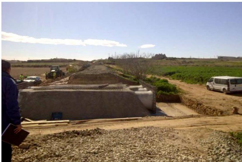
Figura 7. Ejecución de una nueva obra de drenaje en la línea ferroviaria Murcia-Águilas por modificación de las vías de desagüe tras las inundaciones de 2012.
