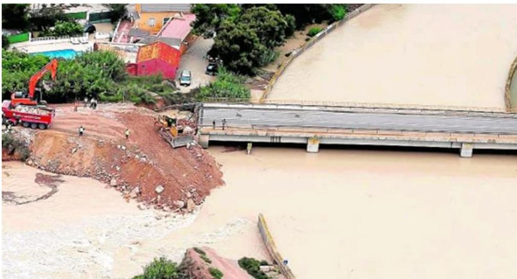
Figura 12: Rotura del encauzamiento del río Segura en Almoradí.
