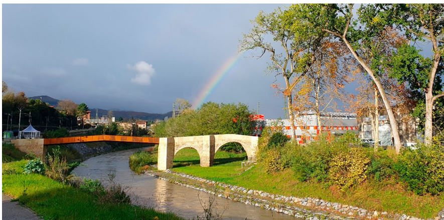
Figura 5. Puente de Mercadillo, en Galdakao, tras las actuaciones. Fuente: URA.
