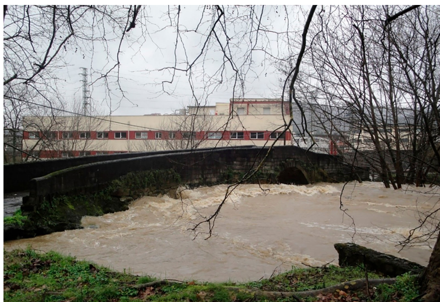
Figura 4. Puente de Mercadillo en avenida, antes de las actuaciones. Fuente: URA.
