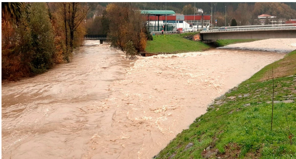
Figura 9. Cadagua en avenida, con la vega recuperada en funcionamiento como cauce complementario.
