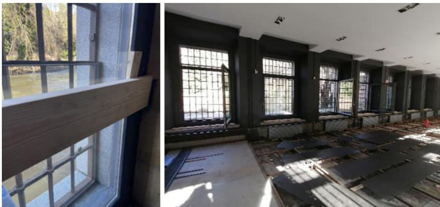
Figura 18. Detalle de refuerzo existente en las ventanas del taller y ventanas de taller.
