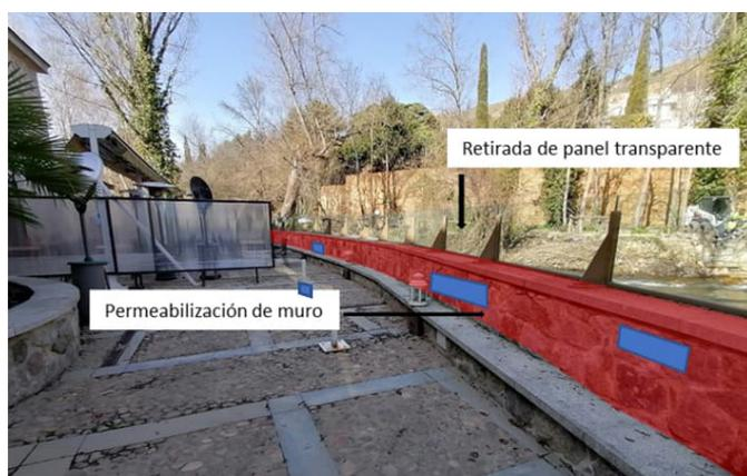
Figura 14. Actuaciones en el muro de protección construido en la terraza del restaurante El Ingenio Chico.
