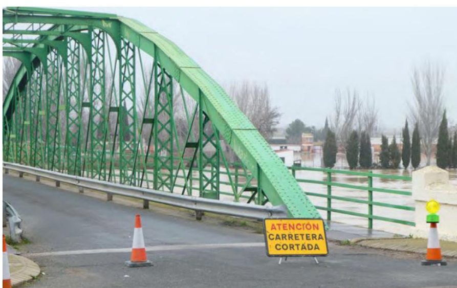
Figura 9. Puente sobre el Ebro a su paso por Gallur (Z).
