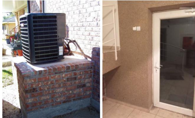
Figura 8. Izq.: Compresor de bomba de calor/frío instalado sobre un plinto.
