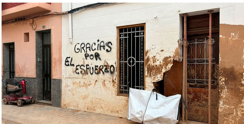
Foto 5. Fachada de vivienda inundada en Paiporta.
