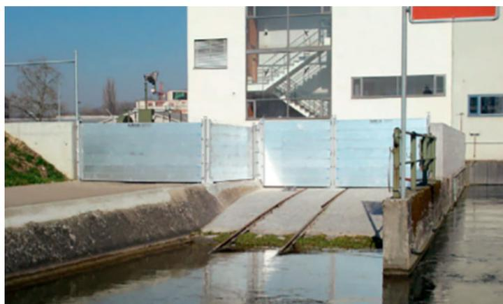
Figura 6. Ejemplo de medidas de resiliencia en edificaciones. Puertas de cierre modulares estancas en muros de cierre. Fuente: Guía para la reducción de la vulnerabilidad de los edificios frente a las inundaciones (CCS, 2017).
