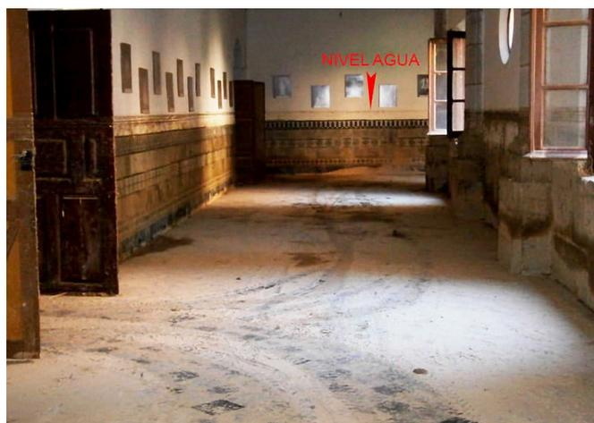
Figura 5. Convento de San Francisco. Acumulación de lodos en paramentos y solados de piedra y daños en los revestimientos de paredes, pinturas y carpinterías de madera.
