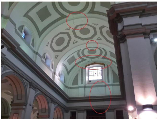
Figura 7. Parroquia de la Encarnación de Santa Fe. Fisuras longitudinales en revestimientos de cúpulas, bóvedas, arcos y paramentos verticales.
